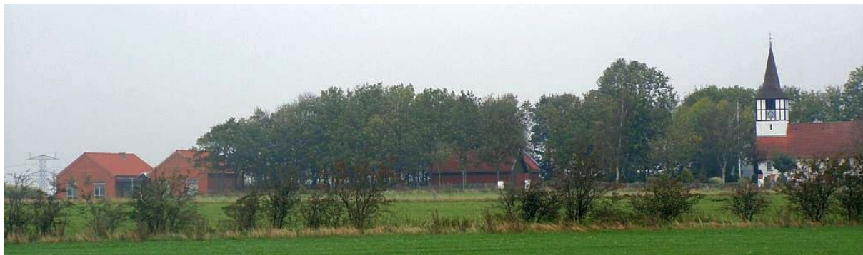
Suldrup kirke og kirkegård set fra Hyldalvej. Til venstre i billedet sognehuset, lidt til højre for midten graverbygningen og helt til højre selve kirken
