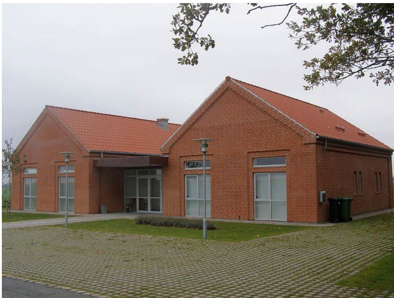
Suldrup sognehus set fra Dalumvej med parkeringspladser på fliserne foran
